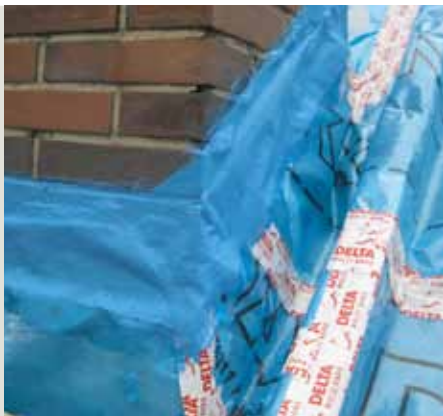
Примыкание к трубе DELTA®-LIQUIXX
