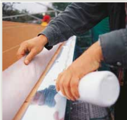
Проклейка на карнизном свесе DELTA®-PREN
