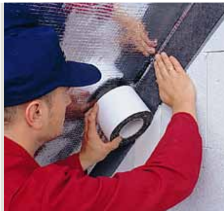
Примыкание к стене DELTA®-FLEXX BAND
