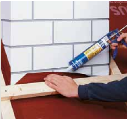
Примыкание к трубе DELTA®-THAN
